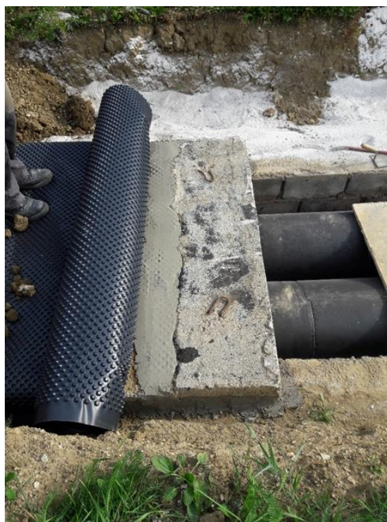
Slika 11: Tesnjenje stikov plošč in vgradnja čepaste folije
